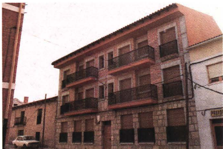
Edificio nuevo mal integrado. Villanubla
